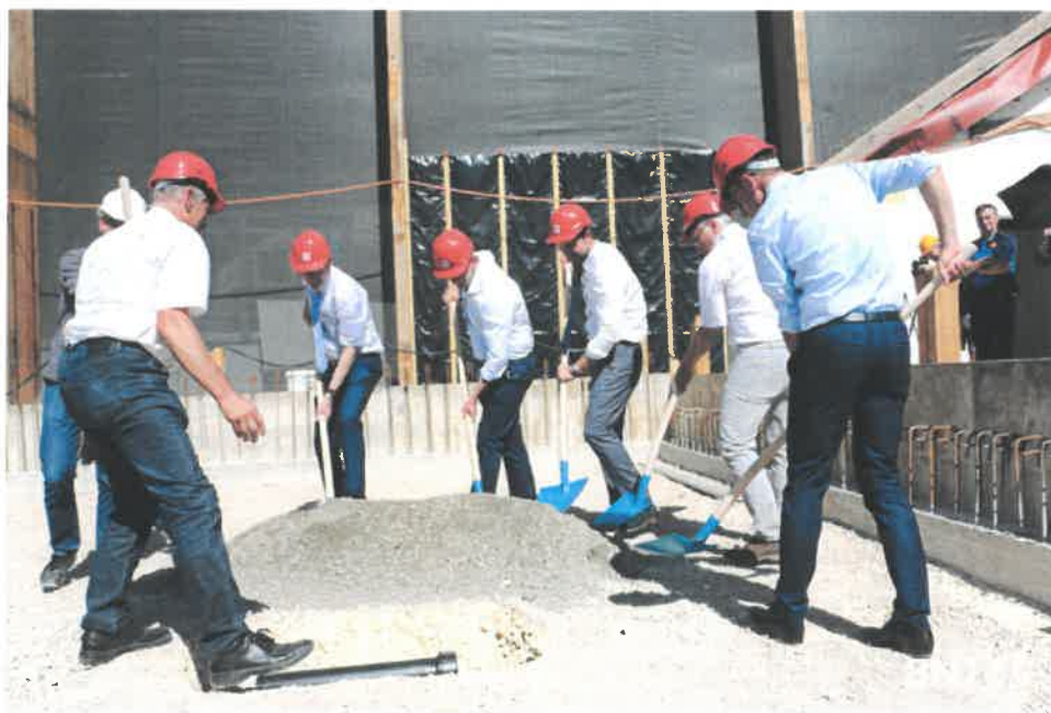
Les plans du complexe et les journaux du jour figurent notamment dans le tuyau enfoui en guise de première pierre symbolique.
