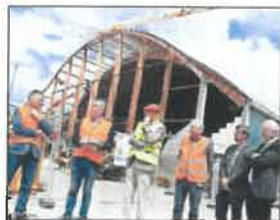
La patinoire est en train d'être démontée. PHOTO: MN
