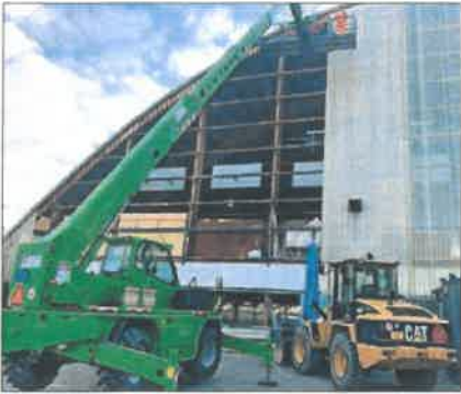
Selon le calendrier des travaux, la partie rénovée devrait être terminée au 1 er octobre 2020 et le deuxième champ de glace à la fin 2021.
