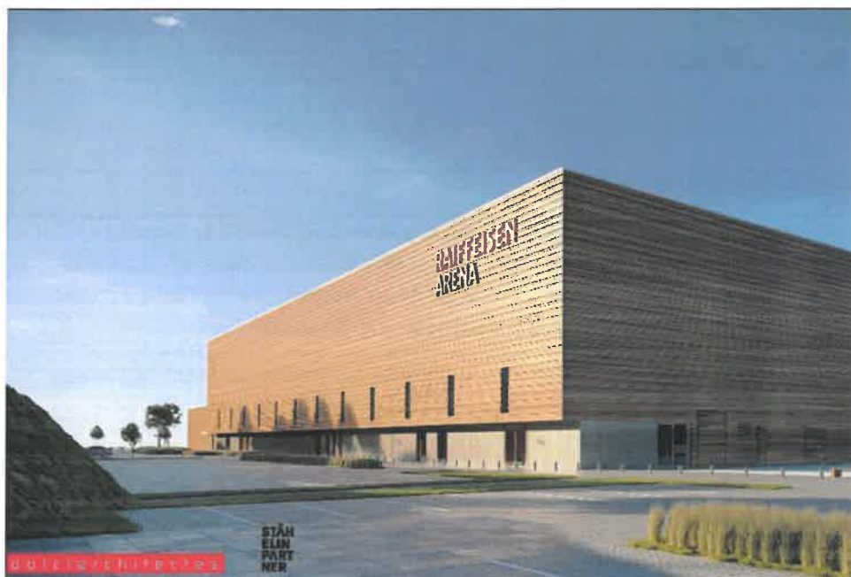
Le projet final de la patinoire à Porrentruy est sous toit.
